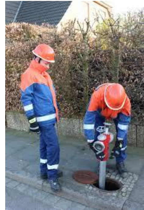
Standrohr setzen
